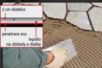
**Pevná pokládka v exteriéru nebo interiéru (s podlahovým vytápěním nebo bez něj)**
