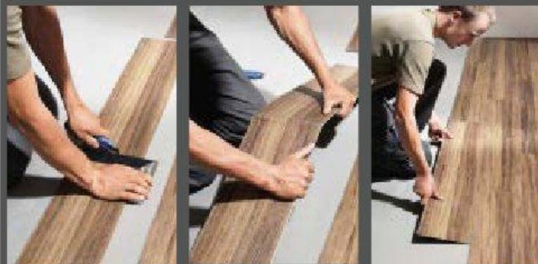
Pokládku začnete tak, že dáte drážku směrem ke zdi a položíte první řadu. Pokládka s UNICLIC systémem je velmi jednoduchá. Přilehlé úhly se zasunou a zacvaknou do sebe.
